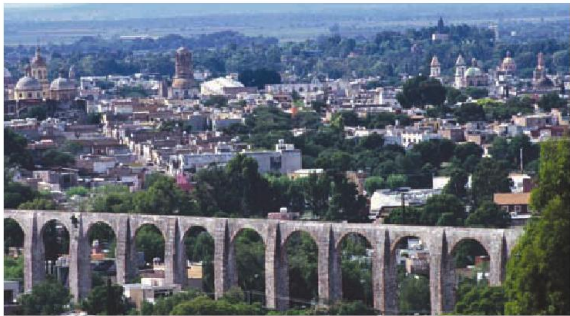
◆ Acueducto de Querétaro, Querétaro.
